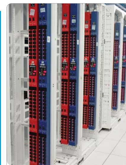
Dominion PX предоставляет точные данные киловатт/час для каждого отдельного устройства центра обработки данных в режиме реального времени.
